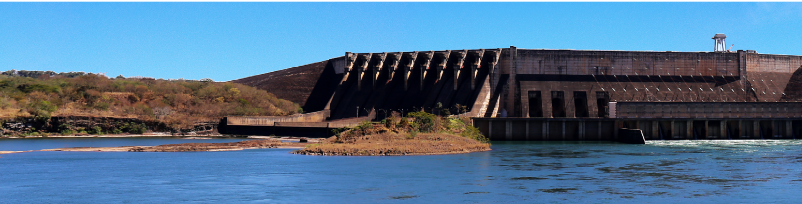
São Simão Hydro Power Plant.
