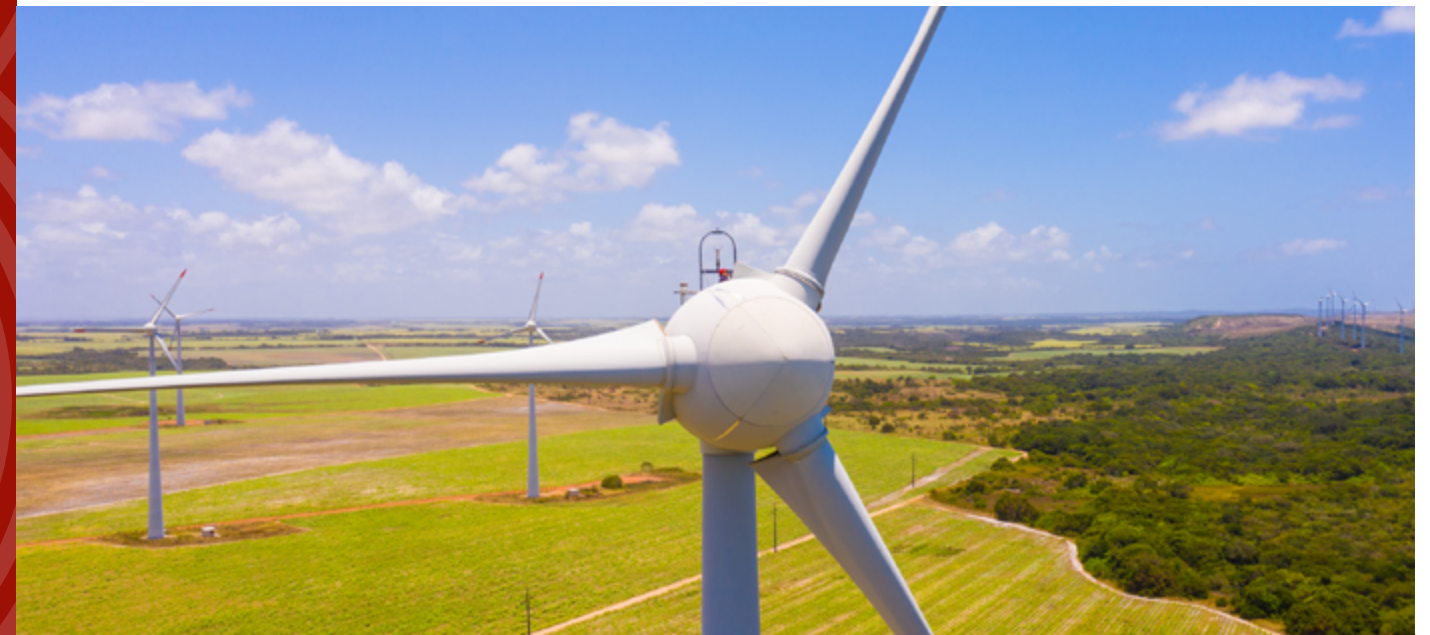
Vale dos Ventos Wind Complex
