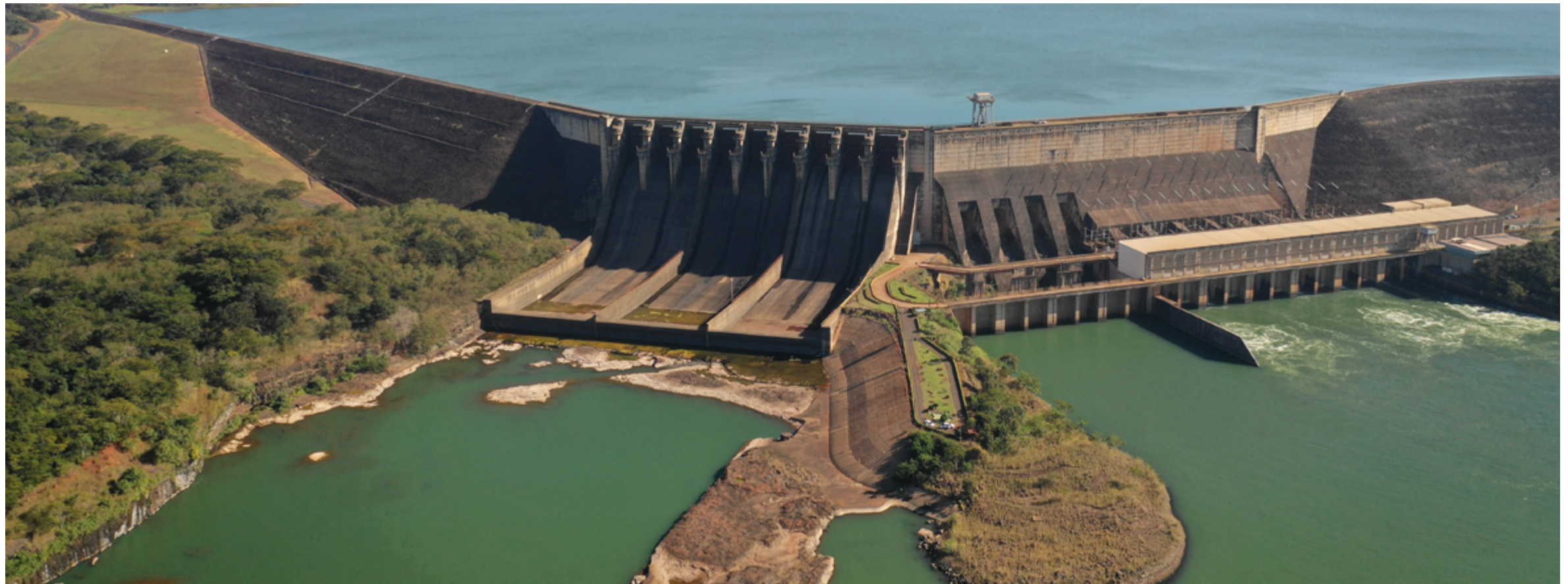
São Simão Hydro Power Plant.
