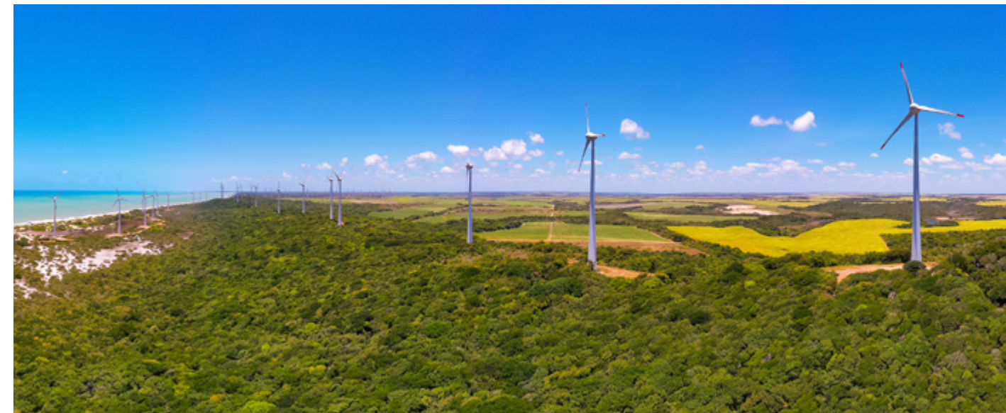
Vale dos Ventos Wind Complex.
