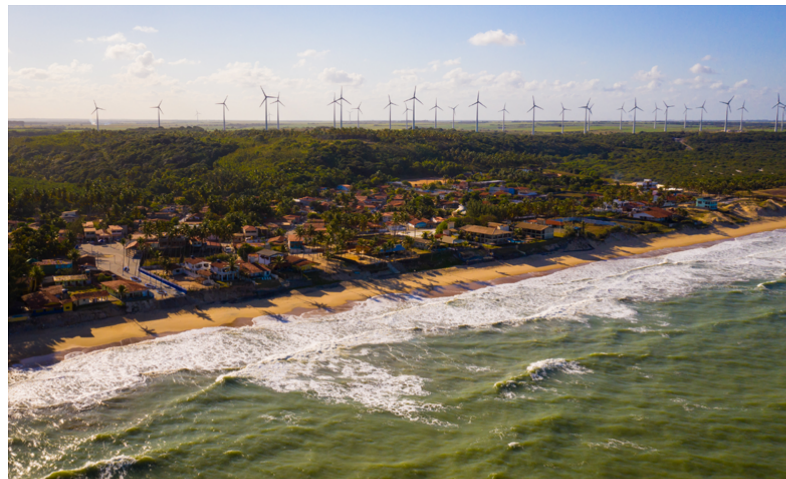
Vale dos Ventos Wind Complex.
