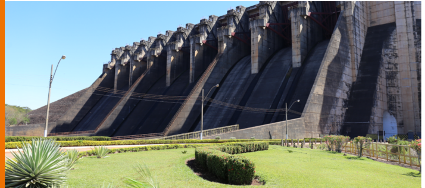
São Simão Hydro Power Plant.
