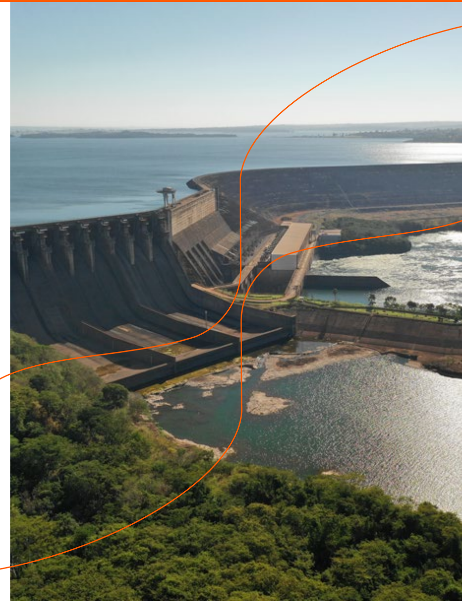
圣西芒水电站，位于米纳斯吉拉斯州和戈亚斯州交界处
