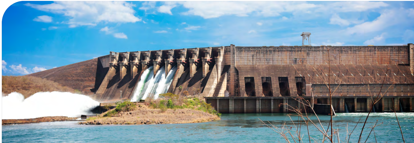
圣西芒水电站
