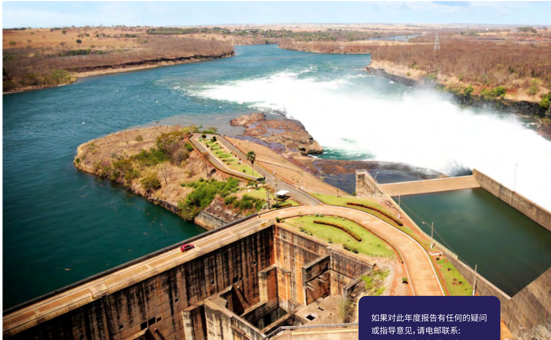
圣西芒水电站
