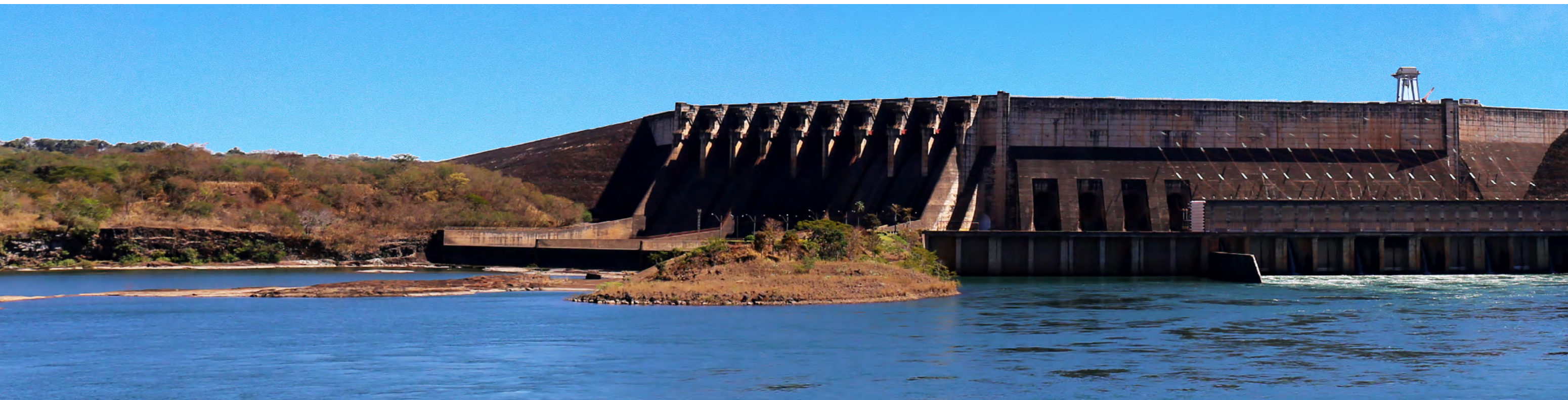
Usina de São Simão.
