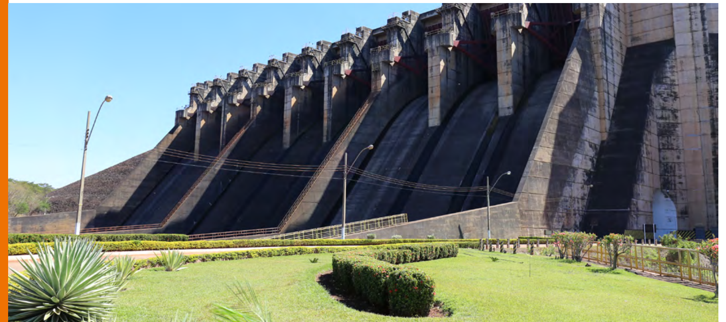
Usina de São Simão.
