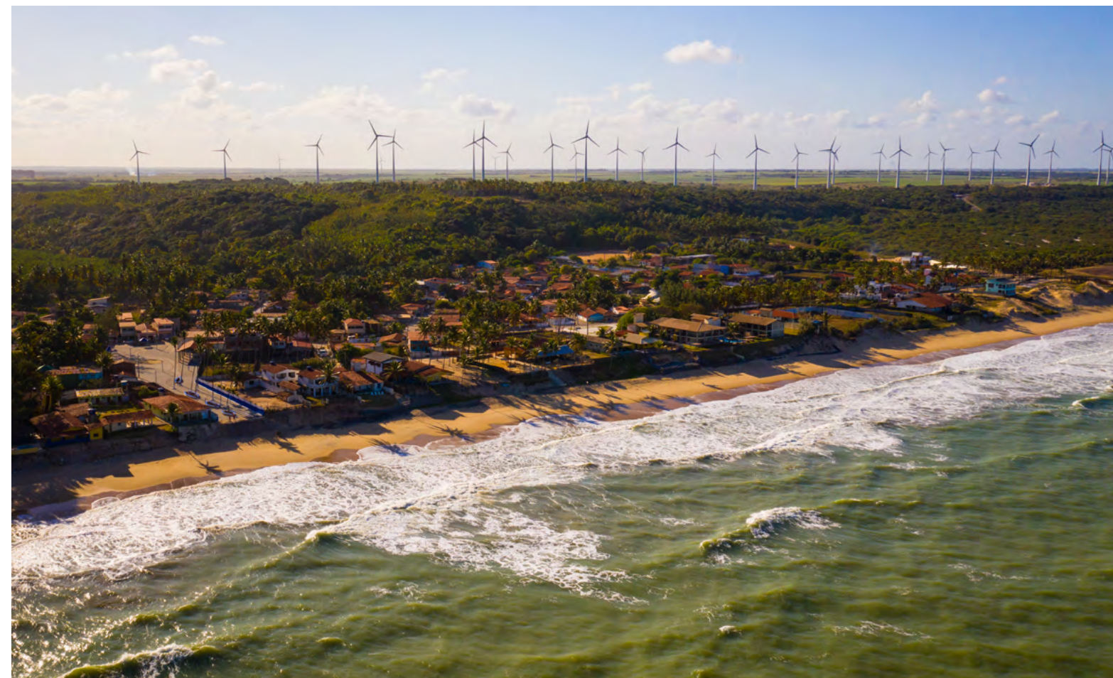
Complexo Eólico Vale do Ventos
