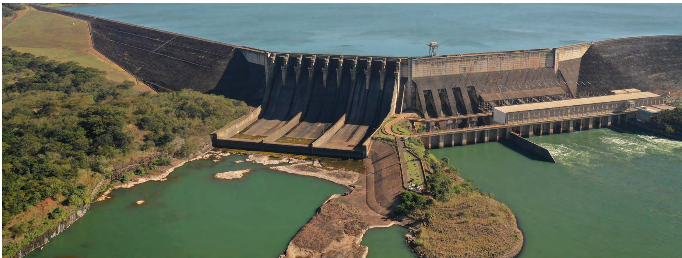
Usina de São Simão.
